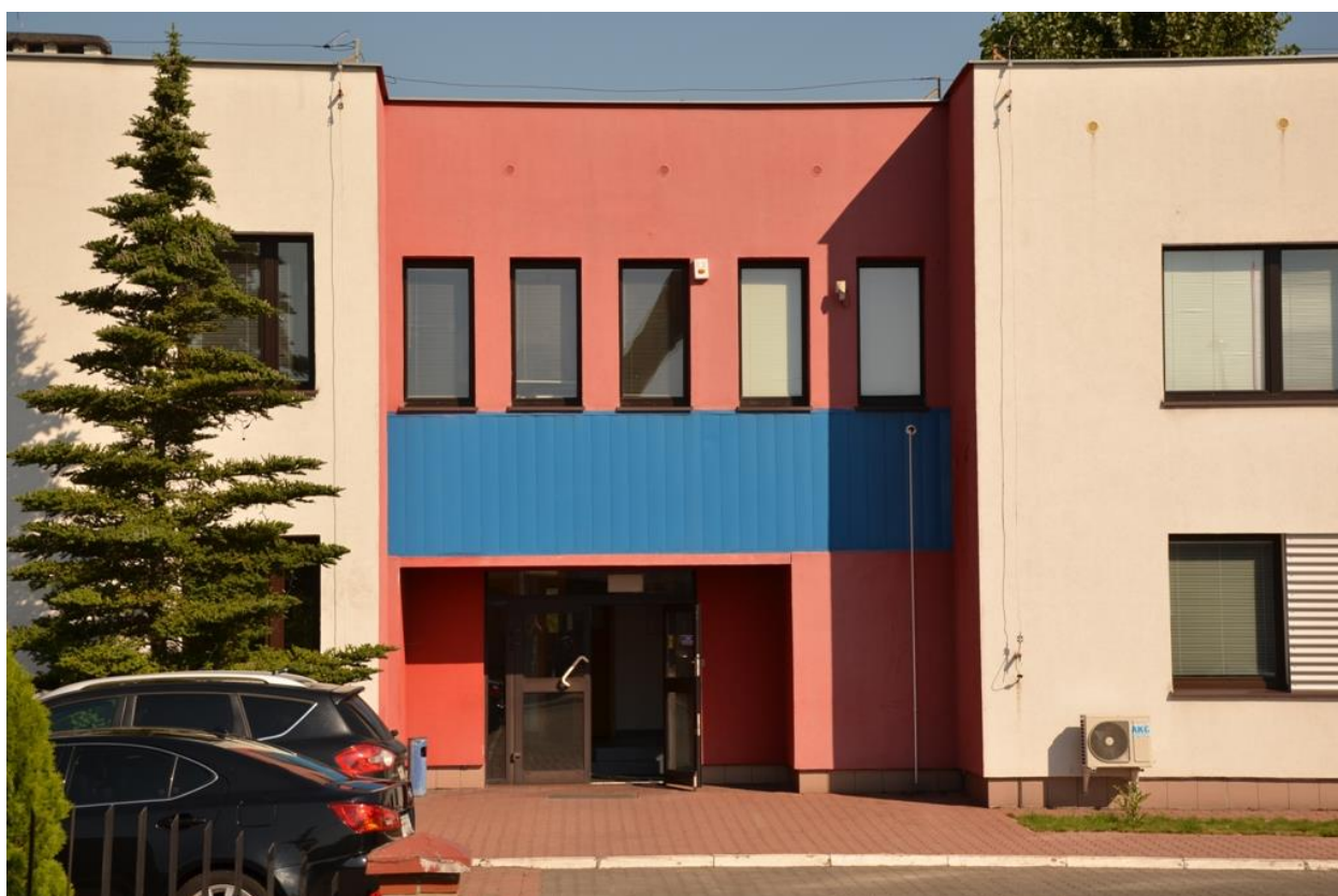
Wejście boczne do budynku administracyjnego
